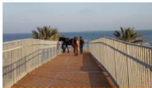
Pasarela sobre la V-21 en Meliana. Anell Verd
