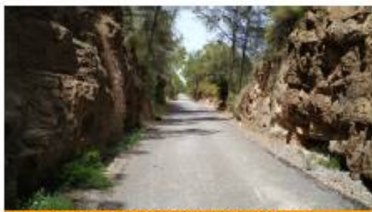
VV Ojos Negros a la salida del túnel de Estivella
